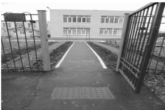
Рисунок 1 – Тактильные плитки на входе в детский сад для слепых детей
